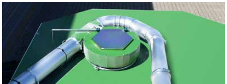
Probenahme Zyklon mit Weiche
